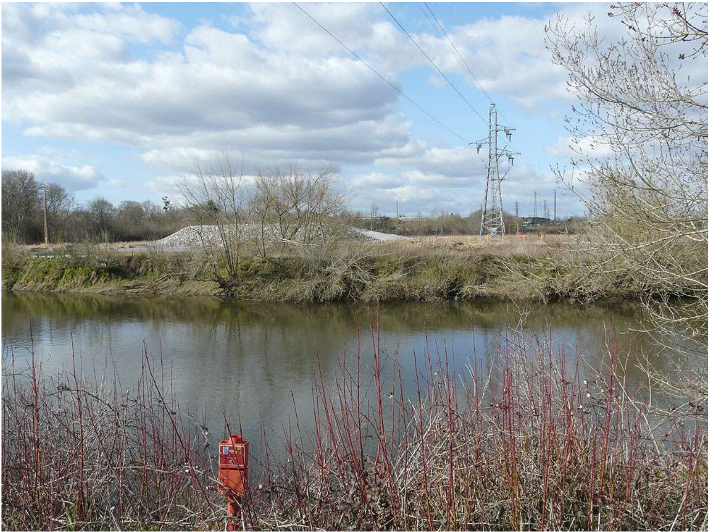
Remblayage en rive droite de l'Adour, côté St Paul lès Dax, pour supporter le viaduc... Photo prise le 8 mars 2012 à 15h47. Crédit photographique : Jean-Pierre ESPIL.
