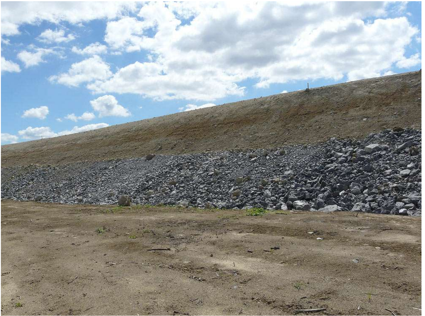
Poursuite de l'apport de remblais sur les 3 km de zone inondable. Les Barthes de l'Adour seront définitivement coupées en deux. Photo prise le 10 août 2013 à 15h53. Crédit photographique : Jean-Pierre ESPIL.
