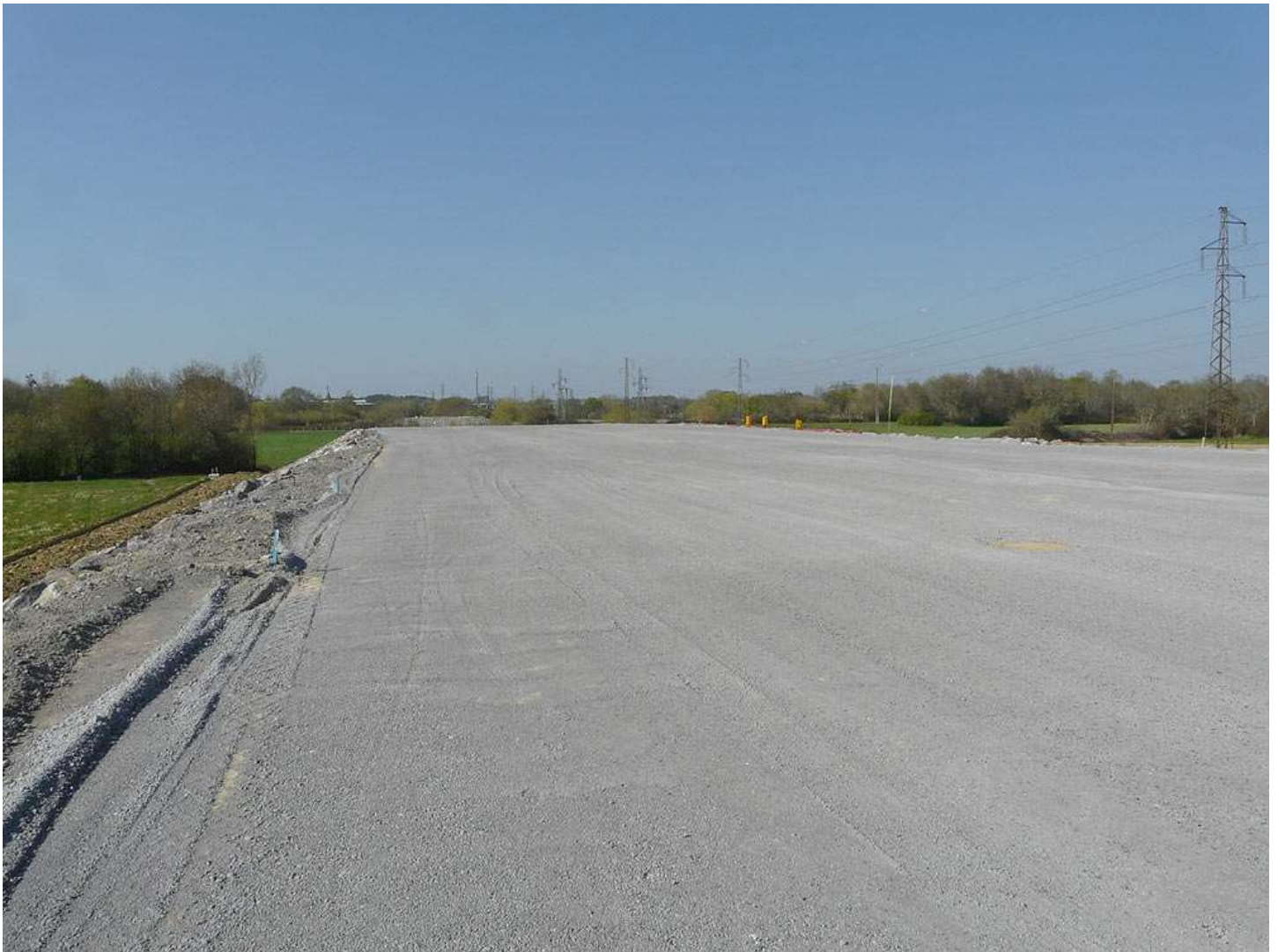
Digue remblayée de 40 m de largeur et de 6 m de hauteur coupant en deux la zone d'expansion des crues, avant la pose du viaduc. Photo prise le 31 mars 2012 à 17h07. Crédit photographique : Jean-Pierre ESPIL.
