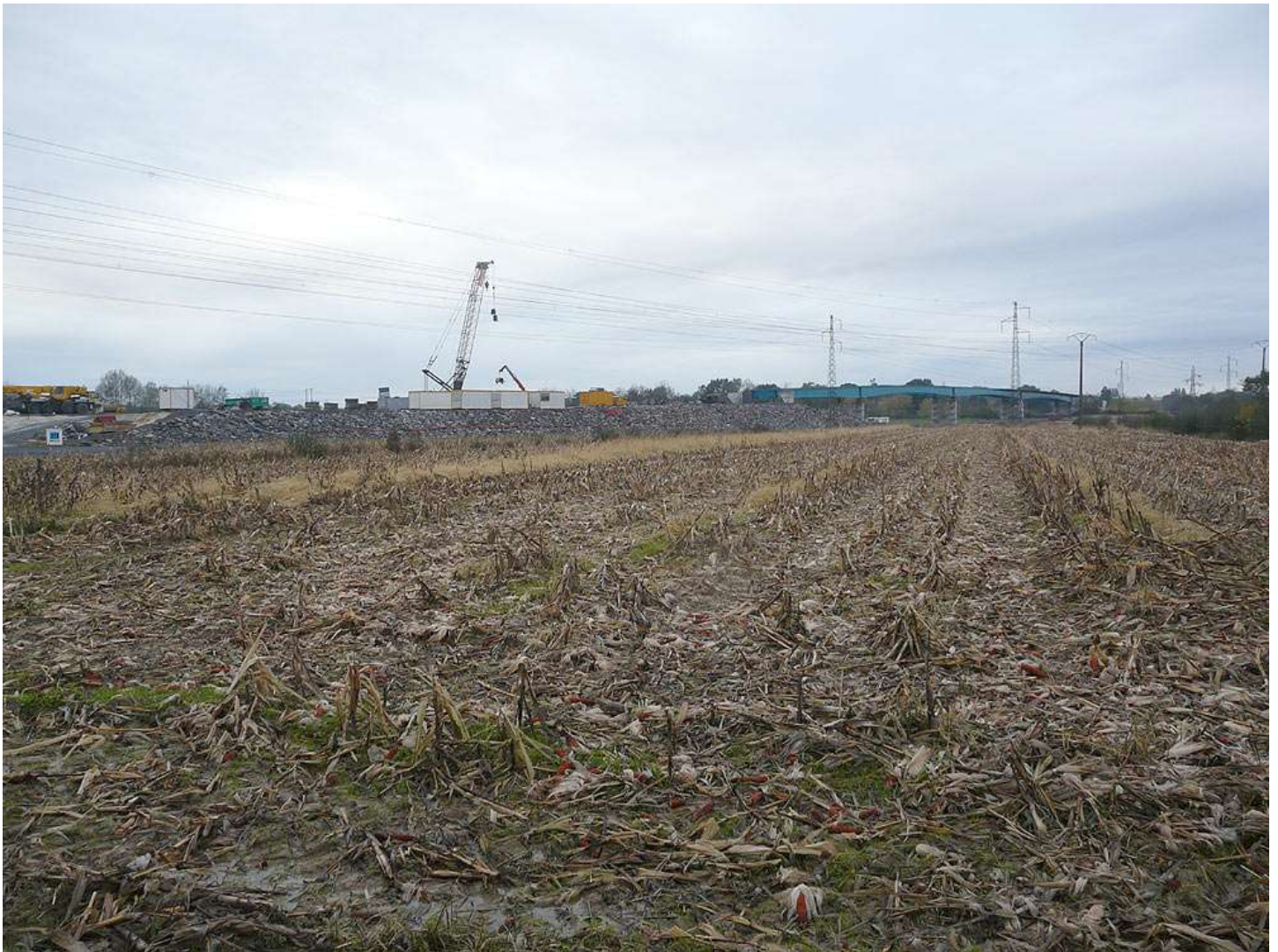
Vue d'ensemble d'une portion de la digue et du viaduc de 5 travées. L'ouverture « naturelle » de 700 à 800 m a été réduite aux 295m du viaduc, soit plus de la moitié. Photo prise le 3 novembre 2012 à 18h14. Crédit photographique : Jean-Pierre ESPIL.
