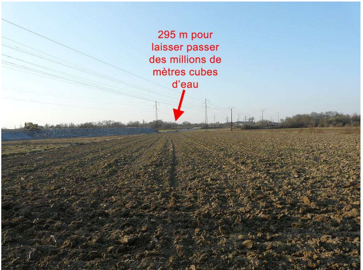
Remblayage en rive gauche et droite de l'Adour. La zone d'expansion des crues est désormais fermée, sauf au niveau de l'ouverture de 295 m destinée à l'évacuation des millions de m 3 de la crue. Photo prise le 15 mars 2012 à 18h04. Crédit photographique : Jean-Pierre ESPIL.
