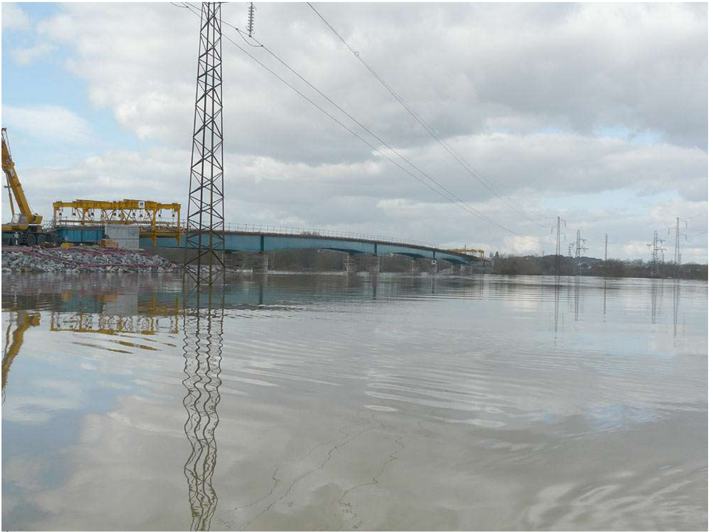
Évacuation des millions de m 3 par l'ouverture de 295 m du viaduc. Photo prise le 15 février 2013 à 15h14. Crédit photographique : Jean-Pierre ESPIL.
