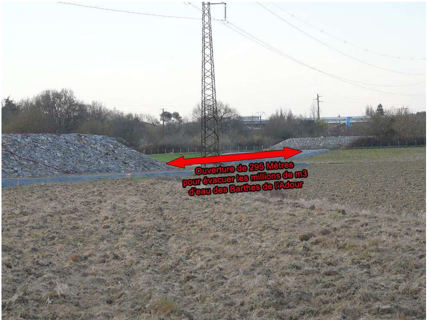
Zoom de l'ouverture de 295 m destinée au viaduc de 5 travées et à l'évacuation des millions de m 3 de la crue. La pile de droite se situe sur la rive droite de l'Adour. Photo prise le 23 mars 2012. Crédit photographique : Jean-Pierre ESPIL.
