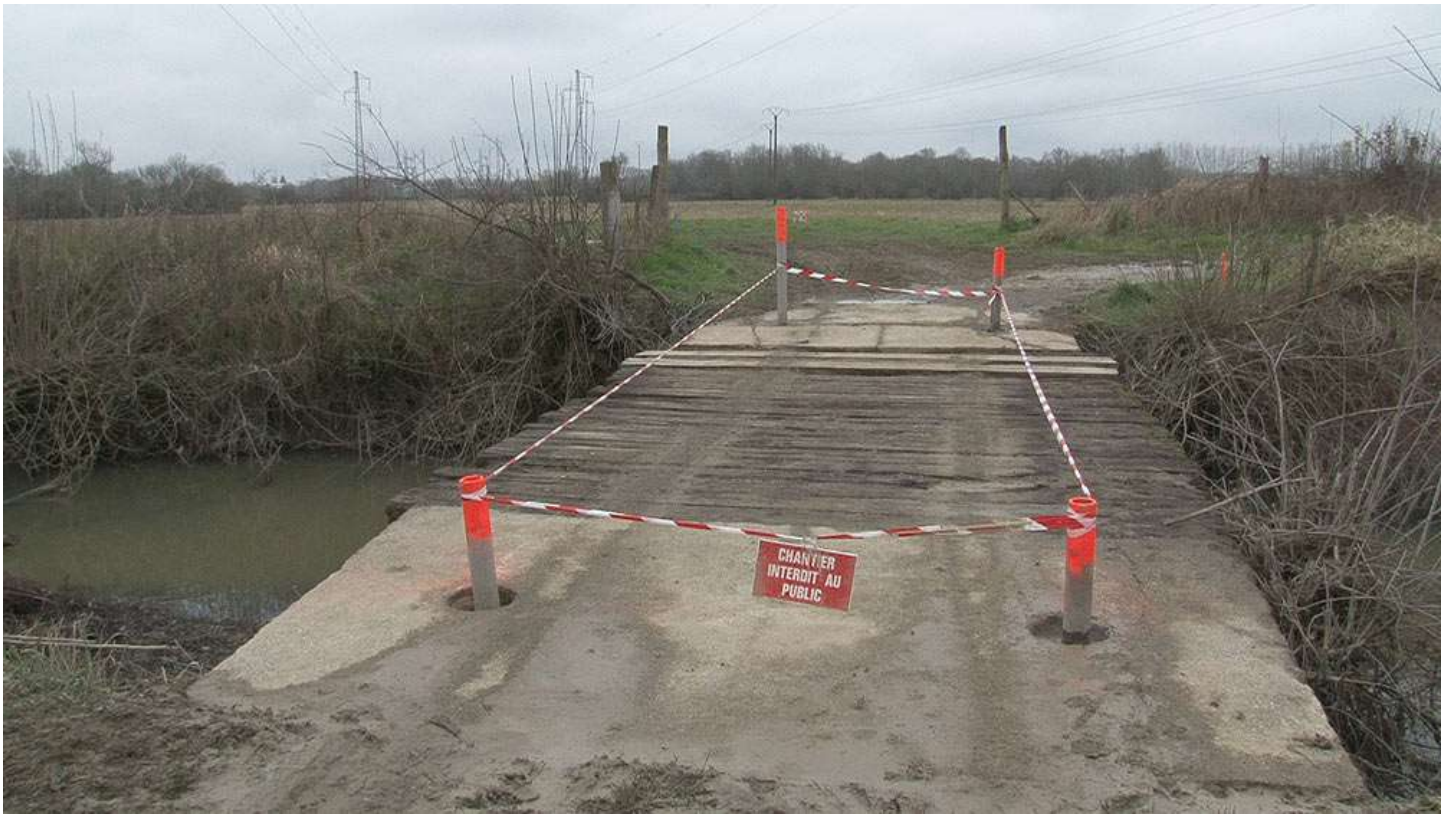
Début des travaux, en 2012 (fabrication d'un pont provisoire en béton armé pour que les camions franchissent le ruisseau de l'Arroudet). La vaste zone d'expansion des crues est toujours sans entraves. Au fond la rive droite de l'Adour et Saint Paul lès Dax. Photo prise le 14 janvier 2012 à 16h22. Crédit photographique : Jean-Pierre ESPIL.
