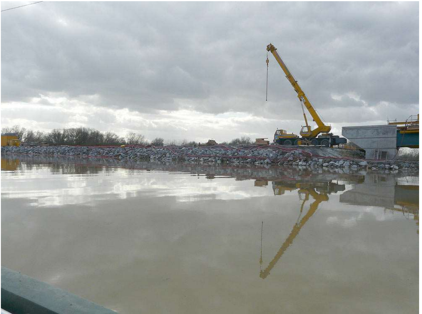
La crue, commencée en janvier 2013, s'évacue lentement jusqu'en mars 2013. On voit bien que l'ouvrage n'est pas « transparent » (comme le Conseil Général des Landes l'a affirmé), pour « permettre aux crues et aux animaux de circuler ». Photo prise le 15 février 2013 à 15h12. Crédit photographique : Jean-Pierre ESPIL.
