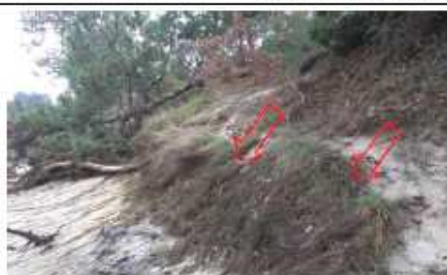
Affaissement en rive droite du Courant
