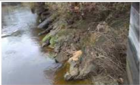
Vue du pied de berge
