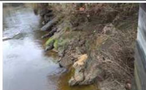
Vue du pied de berge
