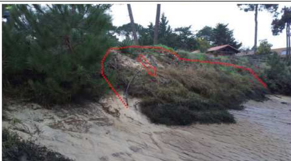
Zone de glissement
