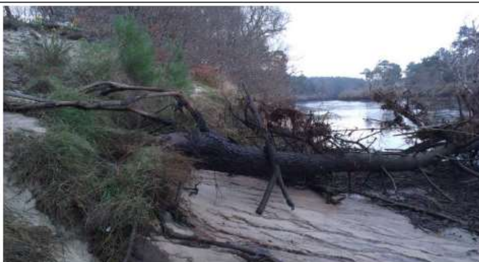
Arbre déraciné et couché en rive droite du courant
