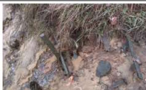
Trace d'un ancien confortement en pieux bois
