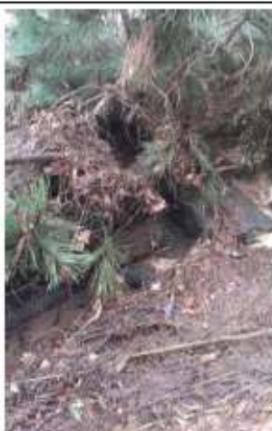
Pied de berge recouvert de brindilles
