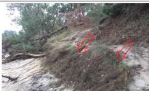
Affaissement en rive droite du Courant
