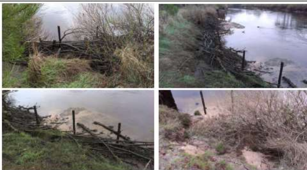
Ancien confortement de pied de berge – Technique végétale tressée (cf. étude historique)
