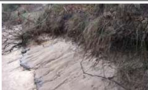
Affouillements en pied de berge
