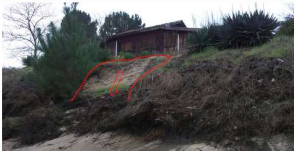
Zone de glissement en pied d'habitation
