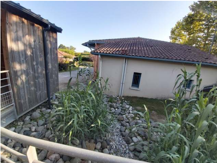
Ensemble cantine, préparation repas
